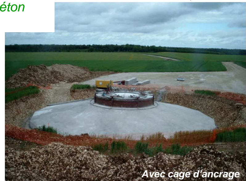
Avec cage d'ancrage NORDEX N90 – 2,3 MW
