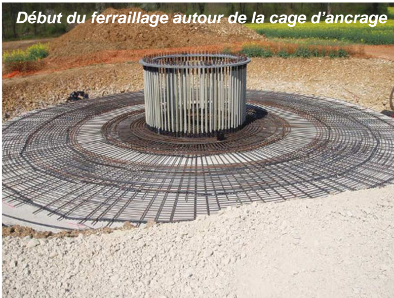
Cage d'ancrage servant de virole
