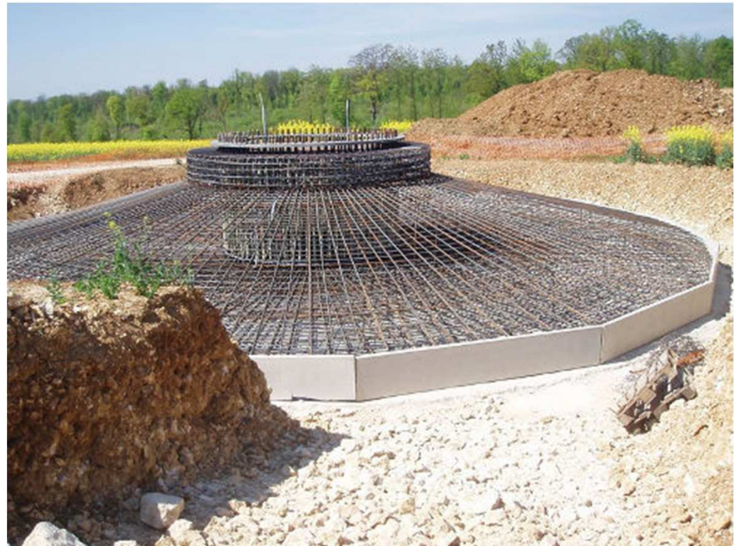
Cage d'ancrage servant de virole
