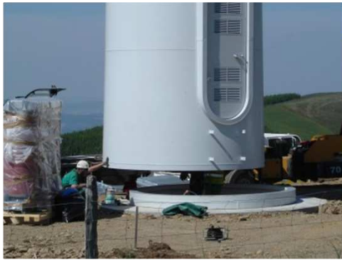
Assemblage des tronçons de mât
