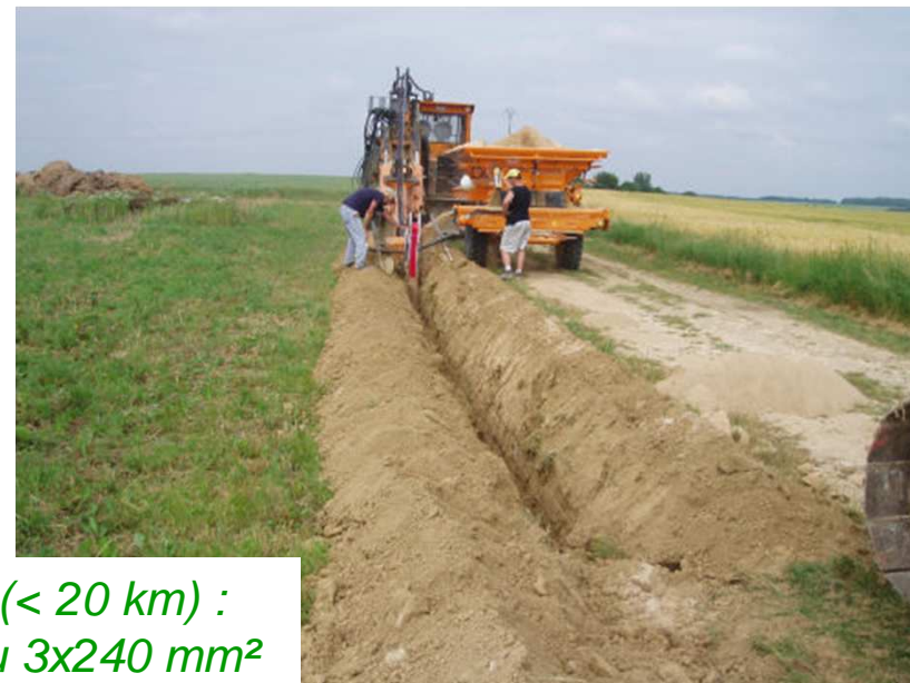
Enfouissement câbles : 0,5 à 1 m de profondeur
